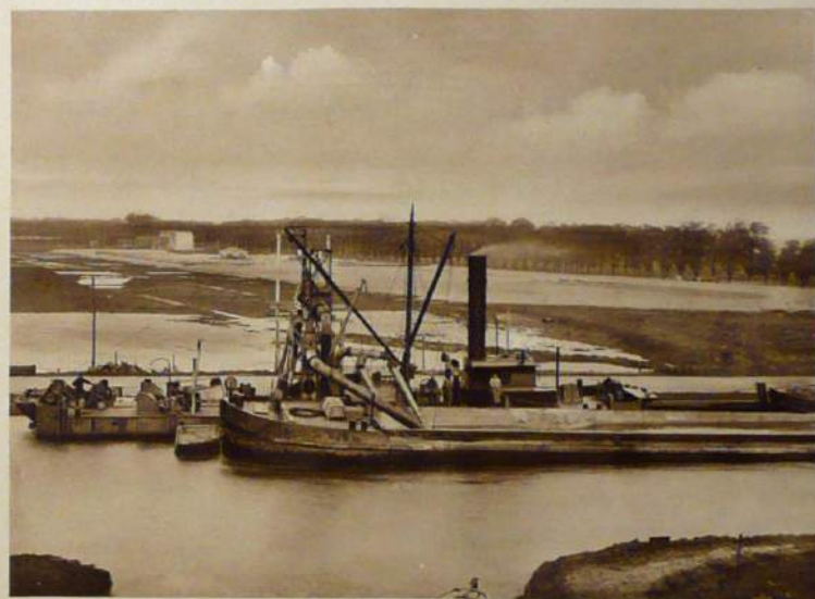
Aufspülen von Bodenmassen
