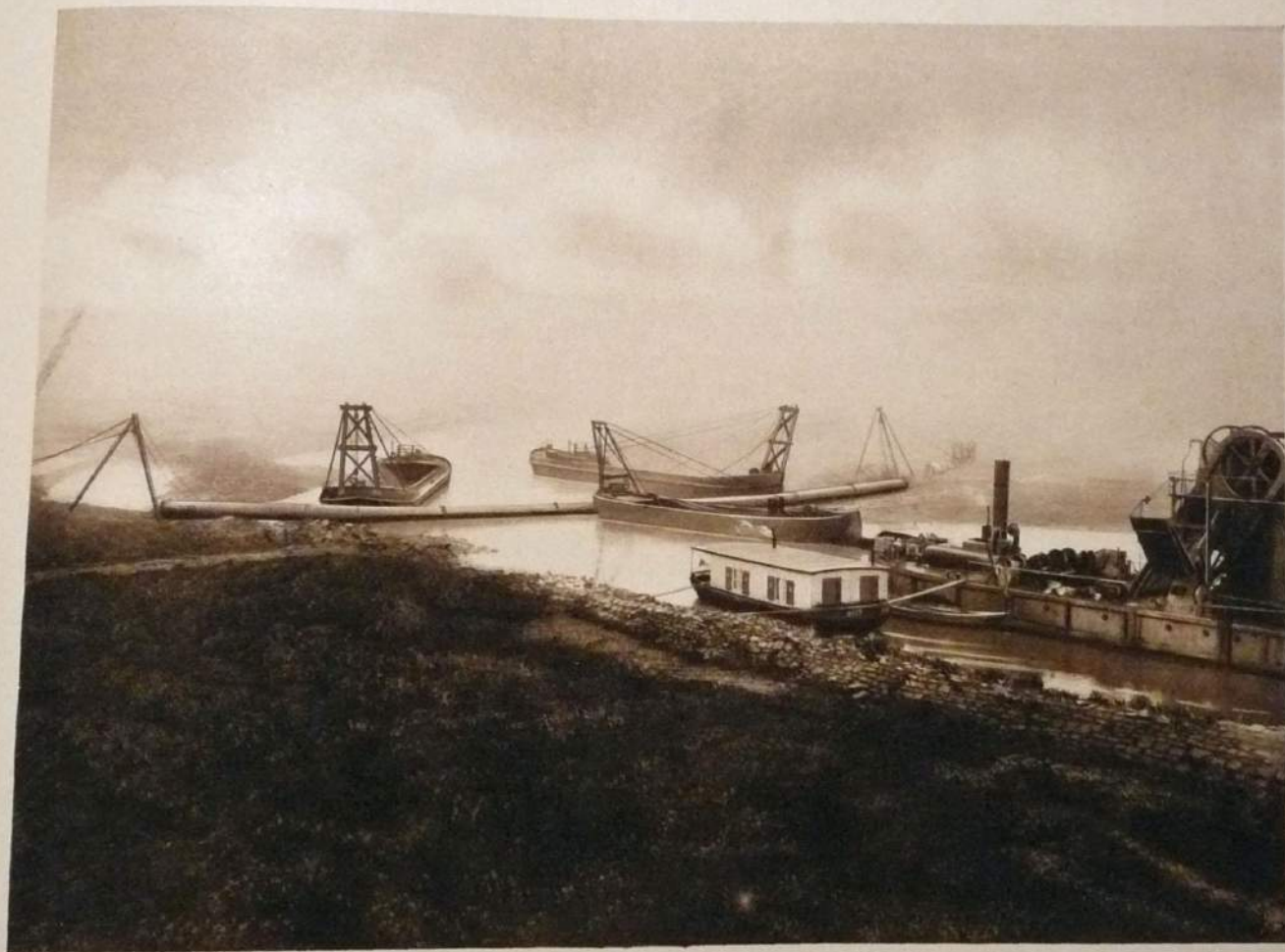
Verlegung eines Dückerrohres durch die Ruhr bei Mülheim Rohrlänge 60 Meter. Rohrdurchmesser 1 Meter
