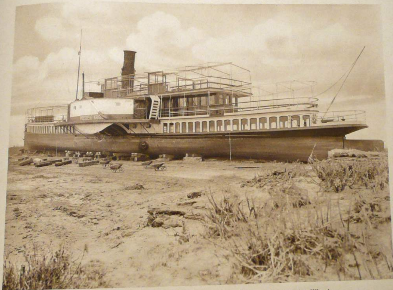
Flottmachung eines bei Hochwasser aufgelaufenen Personendampfers bei Wesel (Ansicht von der Landseite)
