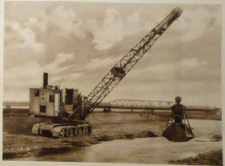
Stromregulierung durch Raupengreifbagger
