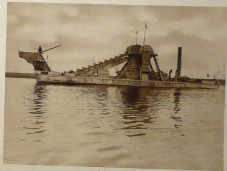
Seebagger Nr. 14 Baggertiefe 20 Meter. Eisenerhalt 570 Liter. Leistung 500 Kubikmeter je Tag.
