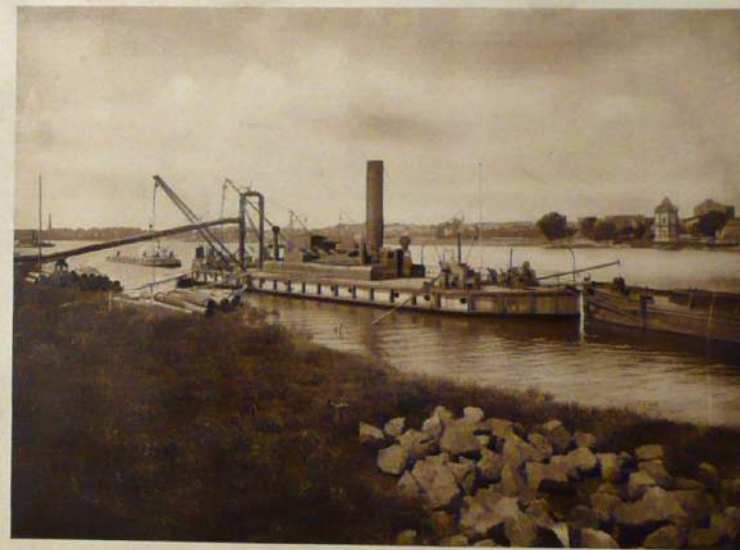
Baggerung und Aufspülung von Boden für die landseitigen Rampen der Straßenbrücke in Schwedt an der Oder
