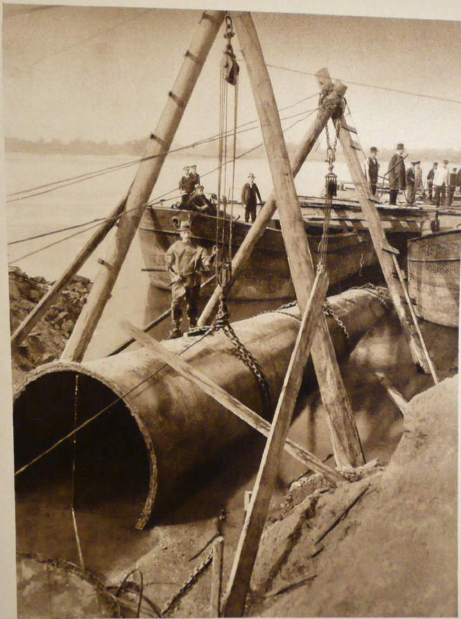
Rohrverlegung in den Rhein bei Alsum Rohrlänge 39 Meter. Rohrdurchmesser 2,10 Meter. Gewicht 70 Tonnen
