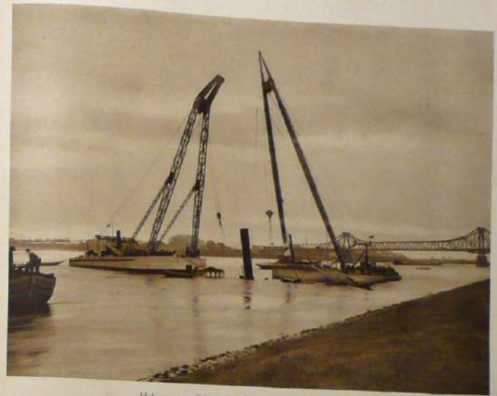
Hebung eines Schleppdampfers mittels Dampfswimkrane (Haken am Dampfer angeschlagen)
