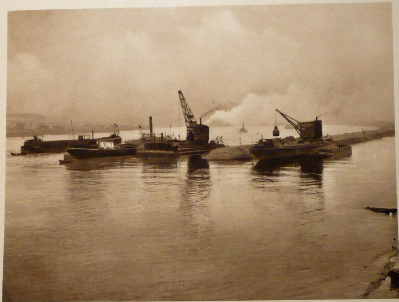
Buhnenbau für einen Industriehafen im Rhein
