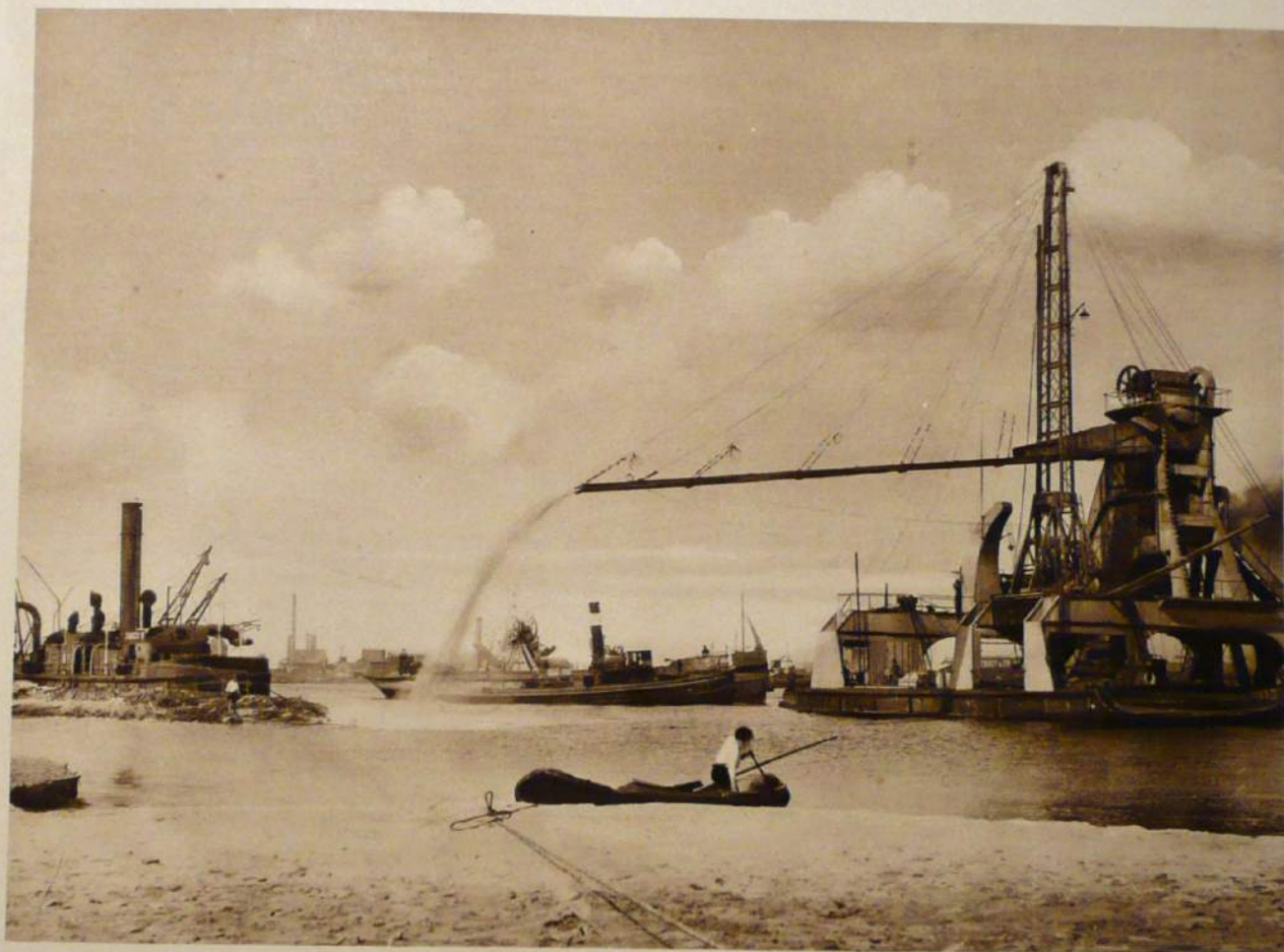
Baggern, Anschütten und Aufspülen von Bodenmassen mittels Spülelevators und Schutensaugers
