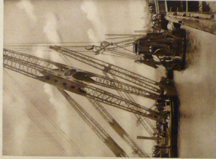
Hilfung eines im Rheider Faden gestankten Dampfzuges mittels Dampfzylinder
