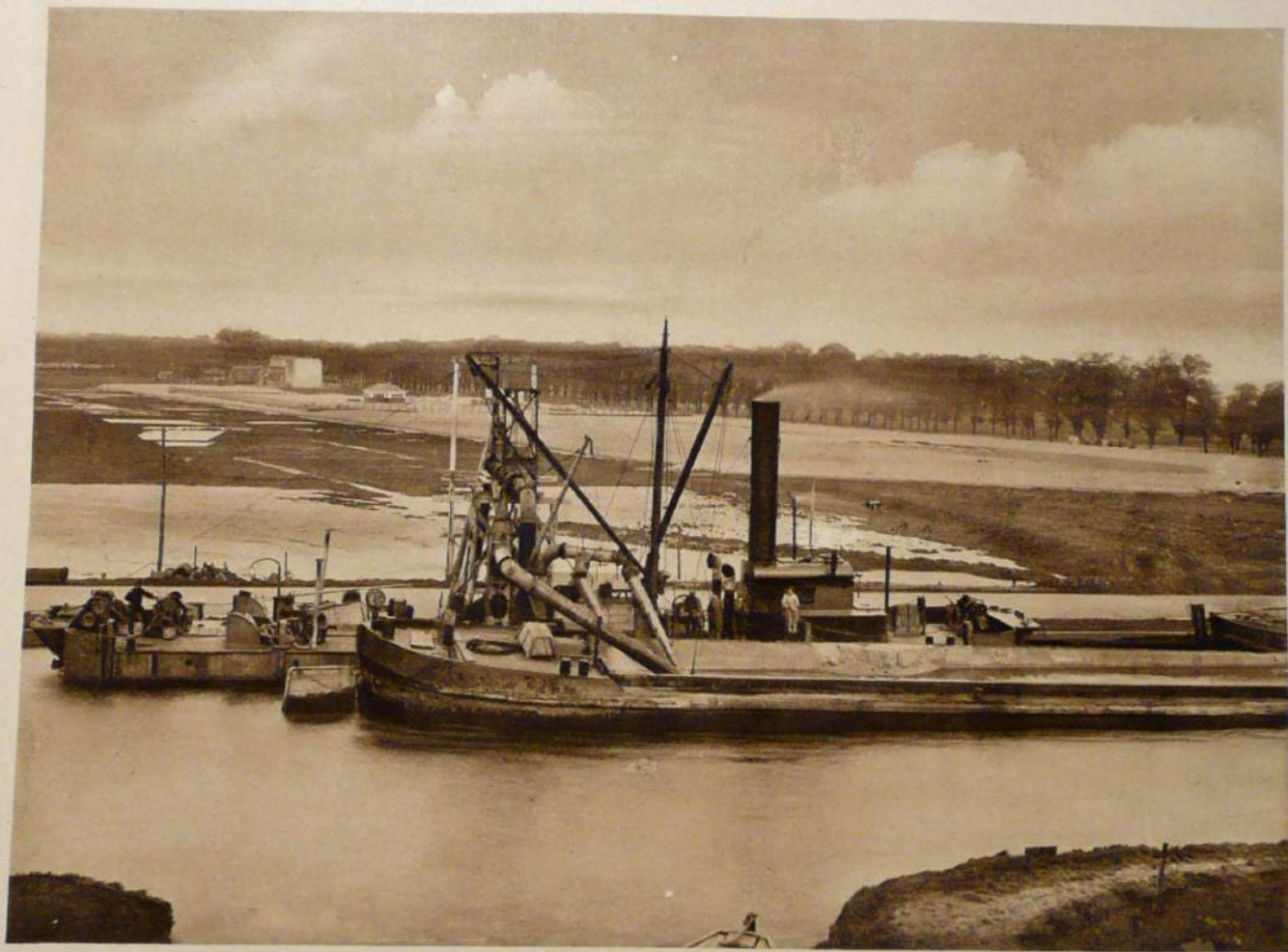
Aufspülen von Bodenmassen
