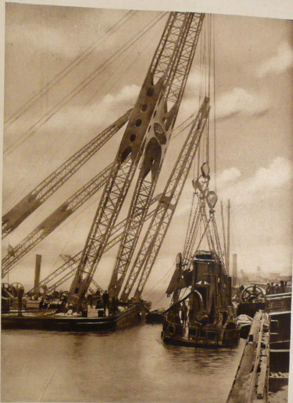
Hebung eines im Ruhrorter Hafen gesunkenen Dampfbaggers mittels Dampfschwimmkranes
