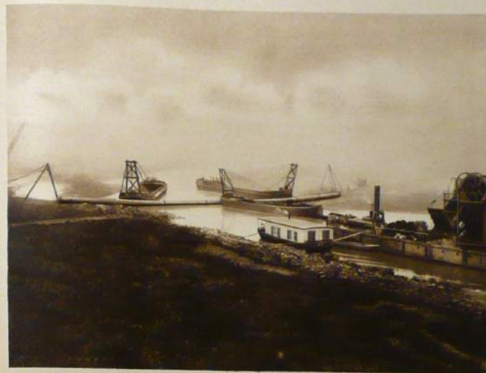
Verlegung eines Dickerohres durch die Ruhr bei Mülheim Rohrlänge 60 Meter. Rohrdurchmesser 1 Meter
