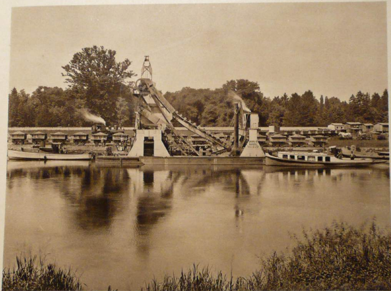
Herstellung des Auedammes an der Fulda bei Kassel
