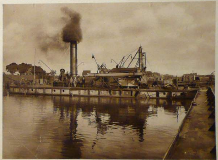
Schutensauger Nr. 15 Leistung 3000 Kubikmeter je Tag bei 1200 Meter Förderweite. Rohrdurchmesser 450 Millimeter
