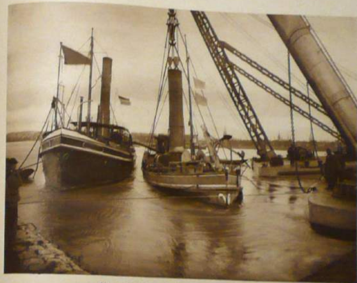
Hebung eines Schleppdampfers mittels Dampfschwinne (Dampfer schwimmend)
