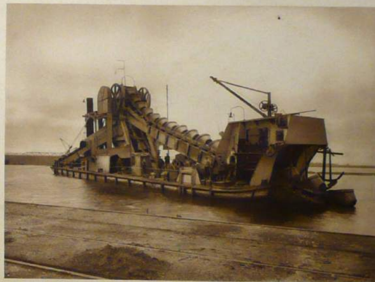
Sechagger Nr. 7 Baggerbreite 18 bis 20 Meter - Förderhöhe 750 und 450 Litter - Leistung 5000 Kubikmeter je Tag
