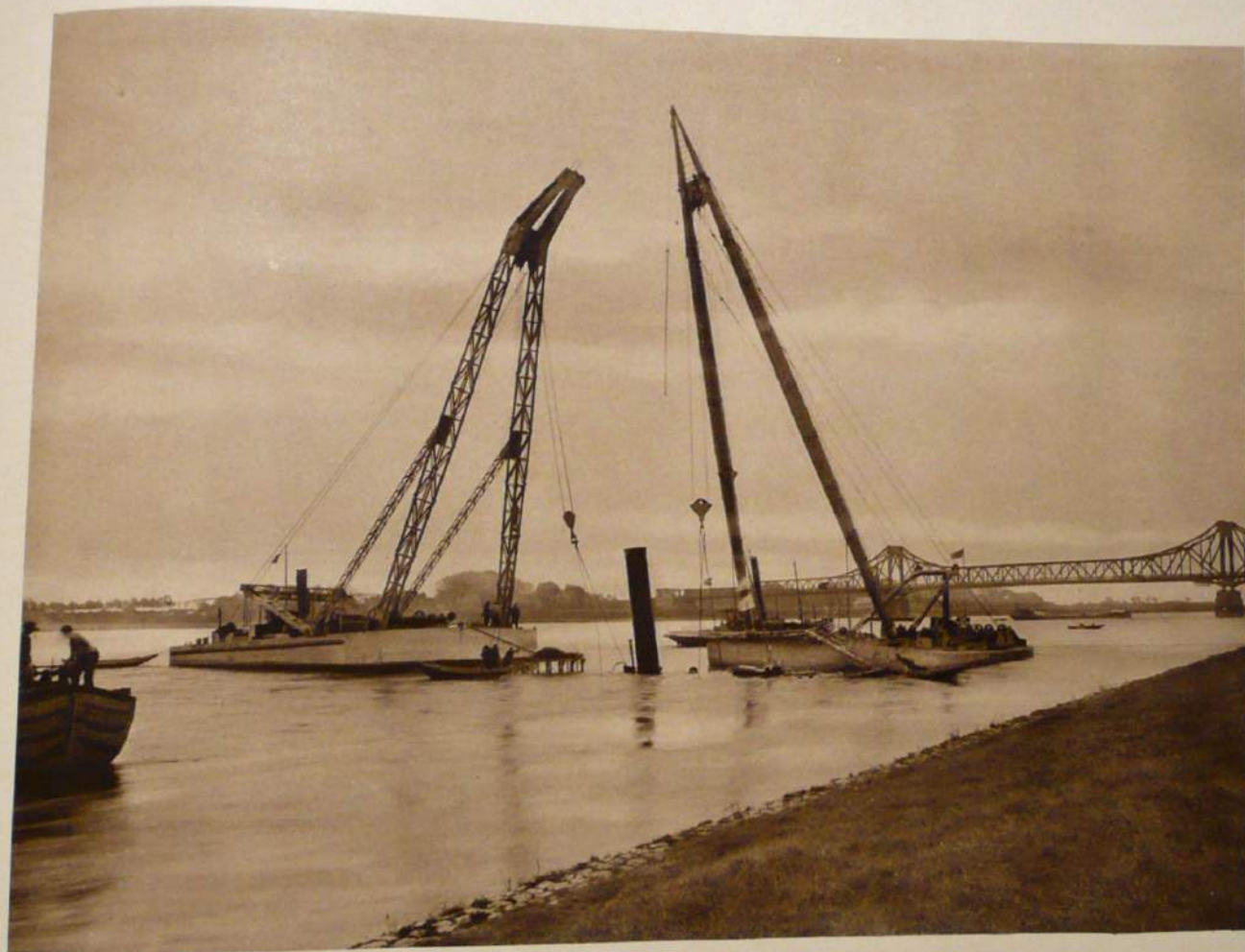
Hebung eines Schleppdampfers mittels Dampfschwimmkranen (Hubketten am Dampfer angeschlagen)
