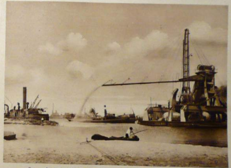
Baggern, Anschütten und Aufspülen von Bodenmassen mittels Spülelevators und Schüttenaigers
