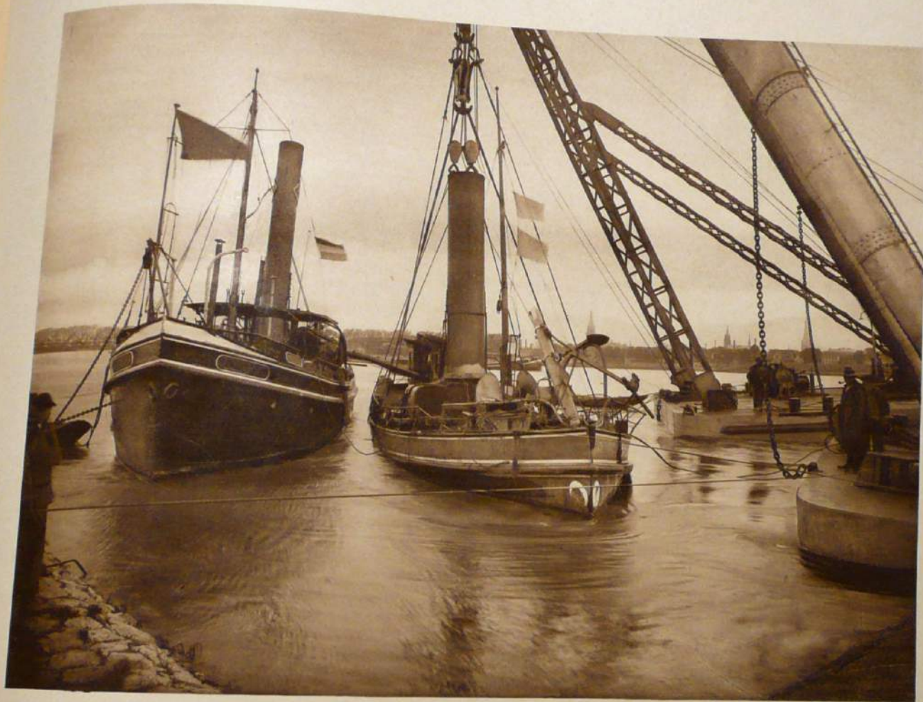
Hebung eines Schleppdampfers mittels Dampfschwimmkrane (Dampfer schwimmend)
