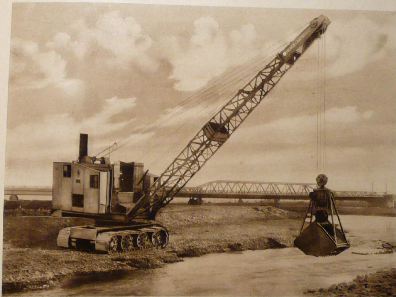
Stromregulierung durch Raupengreifbagger
