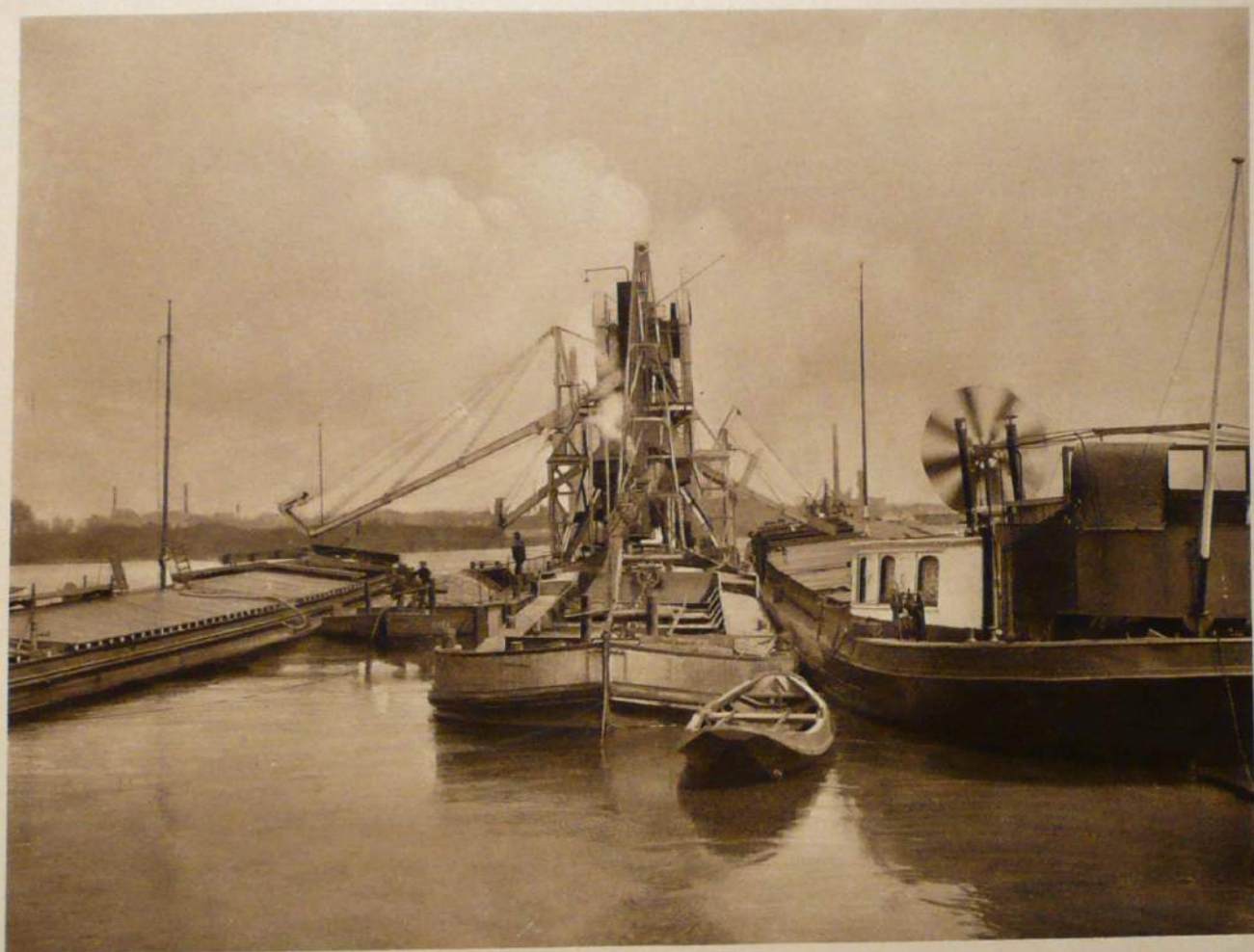
Spezialwaschbagger zur gleichzeitigen Separation von 4 Sorten Kies und Sand
